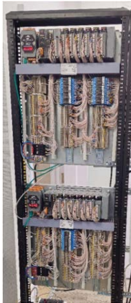
Устройства ввода-вывода из состава СКУТС
